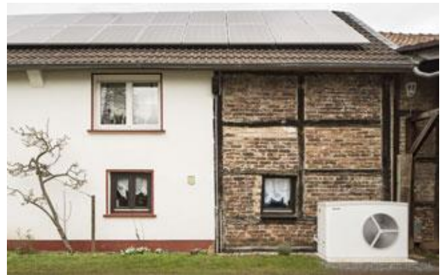
Wärmepumpe für einen Altbau?
